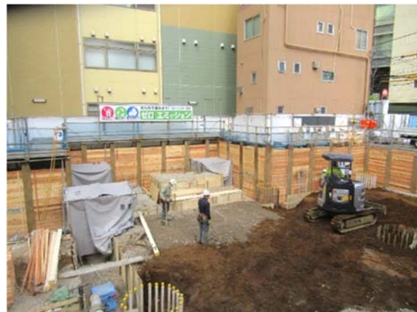
建設状況（地業工事）
