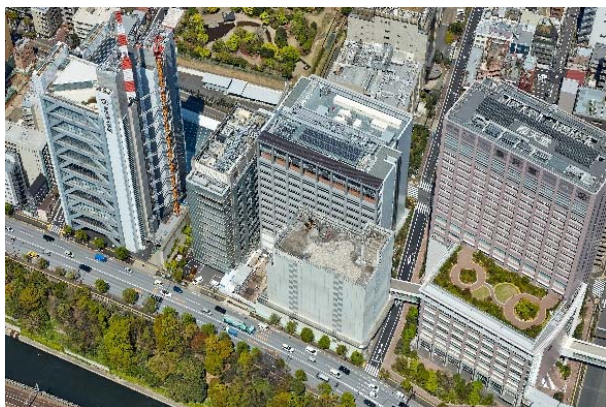
外観（現状：航空写真）
