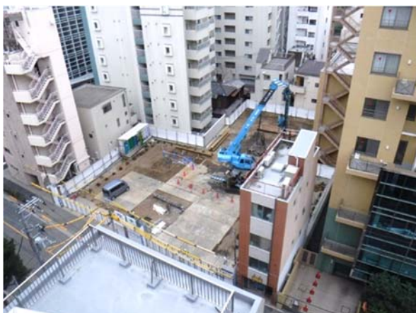
建設状況（山留工事）
